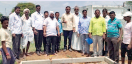
సిమెంట్ రోడ్డు నిర్మాణ వసలు ప్రారంభించిన సర్పంచ్ పాండు రంగారెడ్డి,తదితరులు
