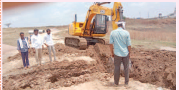
తడ్రలో రోడ్డు నిర్మాణ పనులను ప్రారంభించిన దృశ్యం
